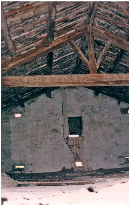
Mas de Servezanne, deuxième niveau de la magnanerie : vue sur la charpente (Photo : F. Privat)
